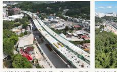
崇謙堂村至九龍坑段一帶工地,正進 沿粉嶺公路的隔音屏障正進行地基 行橋面結構工程。
